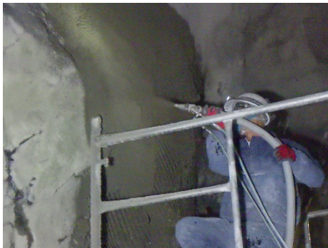
写真－8 モルタル吹付工
