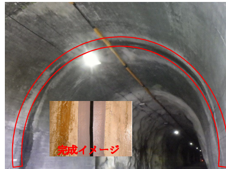
写真－9 線導水工の施工
