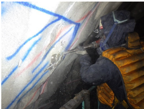
写真－6 既設モルタル吹付撤去
