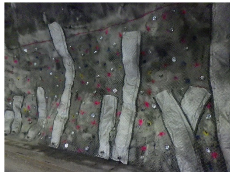
写真－7 排水マット設置
