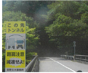
写真-1 1 注意喚起看板（路肩注意）
