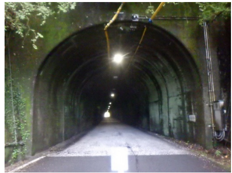
写真-1 小口第二トンネル
